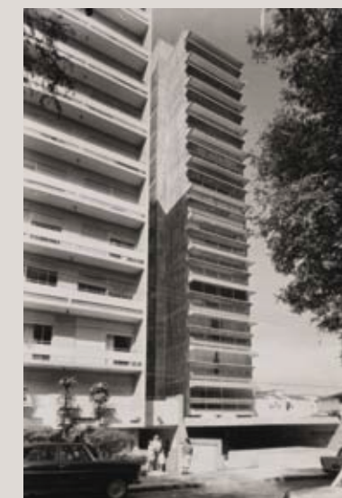
09 y 10 Edificio Guaimbê, Sao Paulo 09 and 10 Guaimbê building, Sao Paulo
