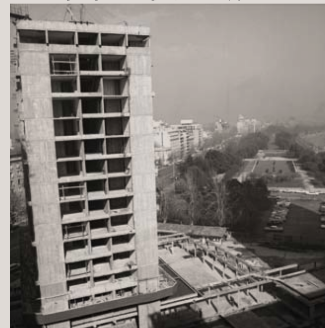
09 Torres de Tajamar, 1965, Providencia. Arquitectos Bresciani, Valdés, Castillo, Huidobro y Bolton, Larraín, Prieto, Lorca 09 Tajamar towers, 1965, Providencia. Bresciani, Valdés, Castillo, Huidobro architects and Bolton, Larraín, Prieto, Lorca architects
