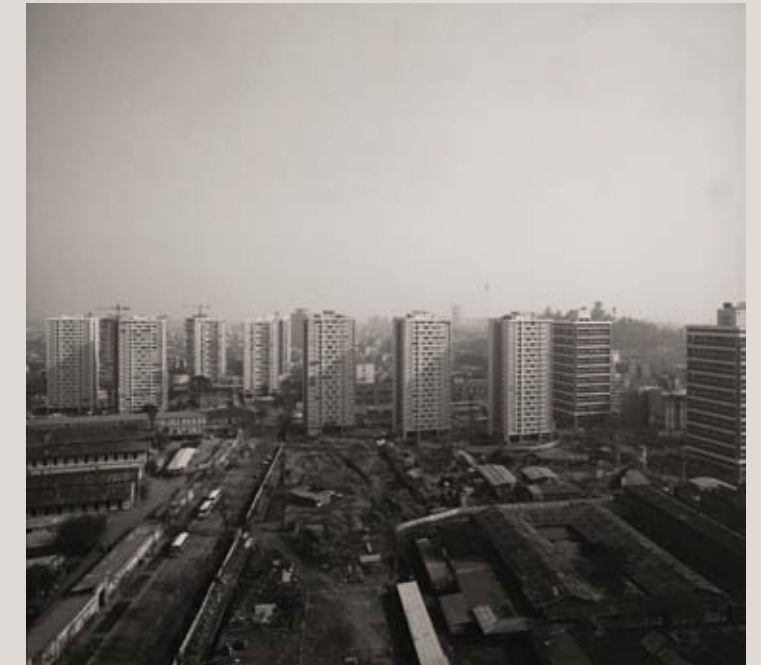
12 Remodelación San Borja, 1972, Santiago. Vista general hacia el norte 12 San Borja renovation, 1972, Santiago. View toward the north
