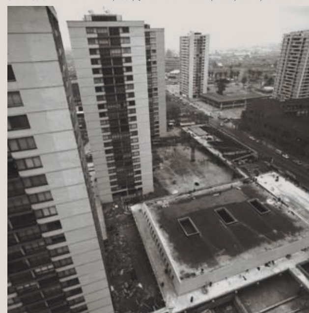
06 Remodelación San Borja, 1972, Santiago 06 San Borja renovation, 1972, Santiago
