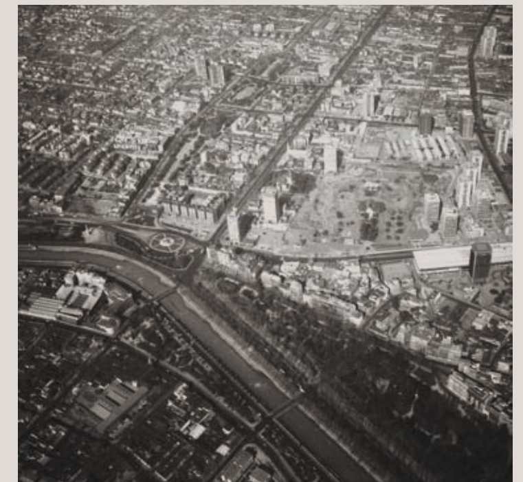
14 Remodelación San Borja, 1972, Santiago 14 San Borja renovation, 1972, Santiago
