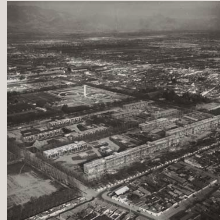
11 Unidad Vecinal Portales, 1962, Quinta Normal. Arquitectos Bresciani, Valdés, Castillo, Huidobro 11 Unidad Vecinal Portales, 1962, Quinta Normal. Bresciani, Valdés, Castillo, Huidobro architects
