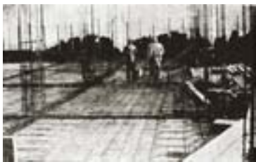
Segundo piso en construcción del Hotel Pucón. Fuente: Revista En viaje N° 7, mayo de 1934.
