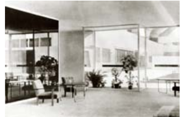
11. Fotografía de la planta baja del Boarding House . Muestra Die Wohnung unserer Zeit . Exposición Deutsche Bauausstellung de 1931. Diseño de Robert Vorhölzer, Max Wiederanders y Walter Schmidt. Fuente: Der Baumeister Vol. 29 N° 7. Verlag Georg D.W. Callwey, München, julio de 1931. Propiedad de The Museum of Modern Art, The Mies van der Rohe Archive, Nueva York.
