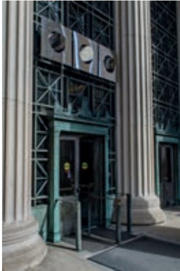
Instalación exterior MIT © Carlo Ratti
