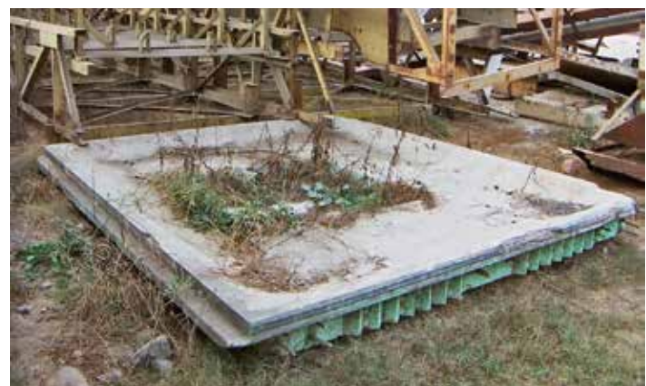
Panel en ruina y abandonado dentro de un botadero de chatarra industrial. Quilpué, Chile, 3 de junio de 2013. Panel ruined and abandoned in dump of industrial junk. © Hugo P. Rodríguez
