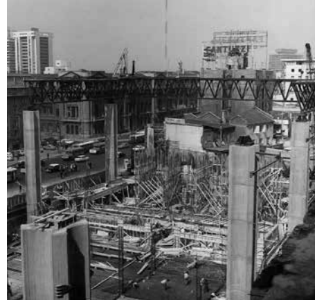
FIG 8 Edificio UNCTAD III. Columnas en construcción, vista hacia Casa Central UC. / Columns under construction, looking towards the UC Central campus. Fuente / Source: Archivo personal de Sergio González.
