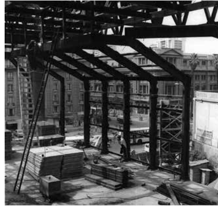
FIG 3 Edificio en construcción, vista hacia Casa Central UC. / Building under construction, view towards UC Central Campus. Fuente / Source: Archivo personal de Sergio González.
