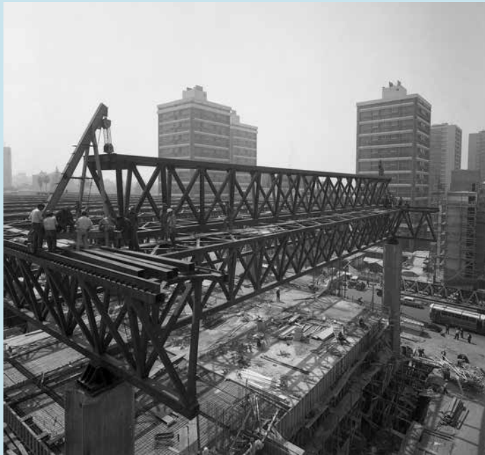
FIG 1 Edificio UNCTAD III. En construcción / Under construction . 1971. © Jack Ceitelis / Gentileza de Galería de imágenes de la CChC.
