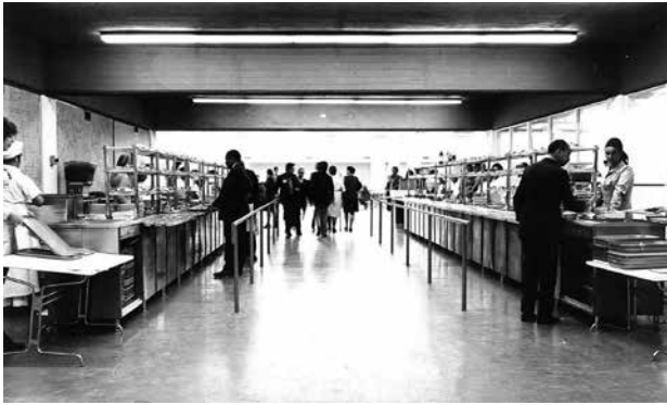
FIG 14 Edificio UNCTAD III. Acceso comedor / Access to the dining hall. Fuente / Source: Archivo personal de Sergio González.
