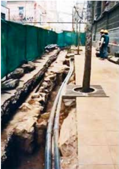
FIG 12a Cimientos de piedra con argamasa de cal de la Catedral de Santiago / Stone and lime-mortar foundation of Santiago's Cathedral. Fotografía / Photograph: Claudia Prado. Fuente / Source: FONDECYT N° 1090325
