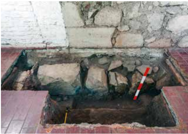
FIG 9 Vista frontal del sistema de cimientos / Front view of the foundation system. Fuente / Source: FONDECYT N° 1130628
