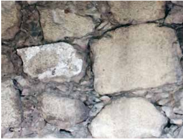
FIG 4a Detalle mampostería de piedra original / Original stone masonry detail. Fuente / Source: FONDECYT N° 11130628
