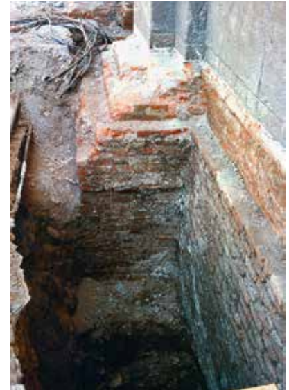
FIG 12c Cimientos de piedra con argamasa de la ex Real Audiencia de Santiago. Excavaciones realizadas en el marco de la construcción de la Estación Metro Plaza de Armas / Stone and mortar foundation of the former Real Audiencia in Santiago. Excavations performed during the construction of Plaza de Armas Subway Station. Fotografía / Photograph: Claudia Prado, 1997.
