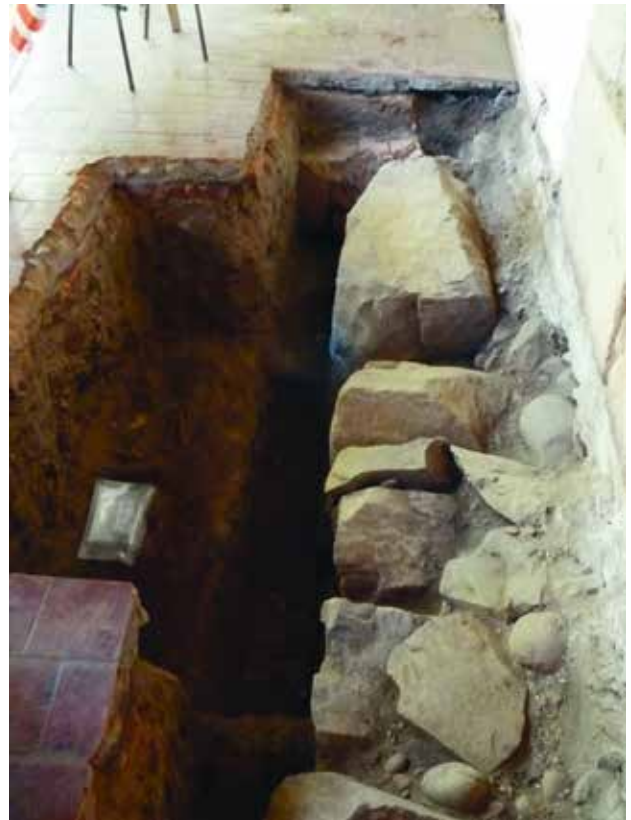
FIG 10 Vista superior del muro de contención lateral del sistema de cimientos / Top view of the foundation's retaining lateral wall. Fuente / Source: FONDECYT N° 1130628
