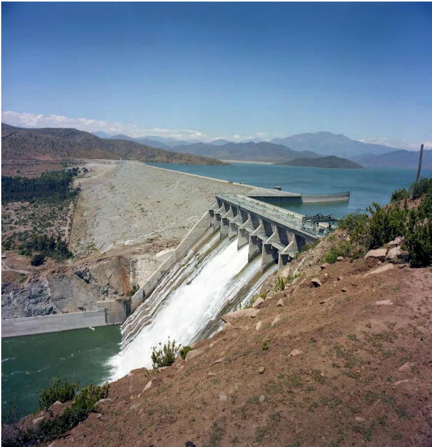
Embalse La Paloma. Constructora Gardilcic Ltda., 1983. / La Paloma reservoir. Gardilcic Construction Company Ltd., 1983. © Colección Museo Histórico Nacional
