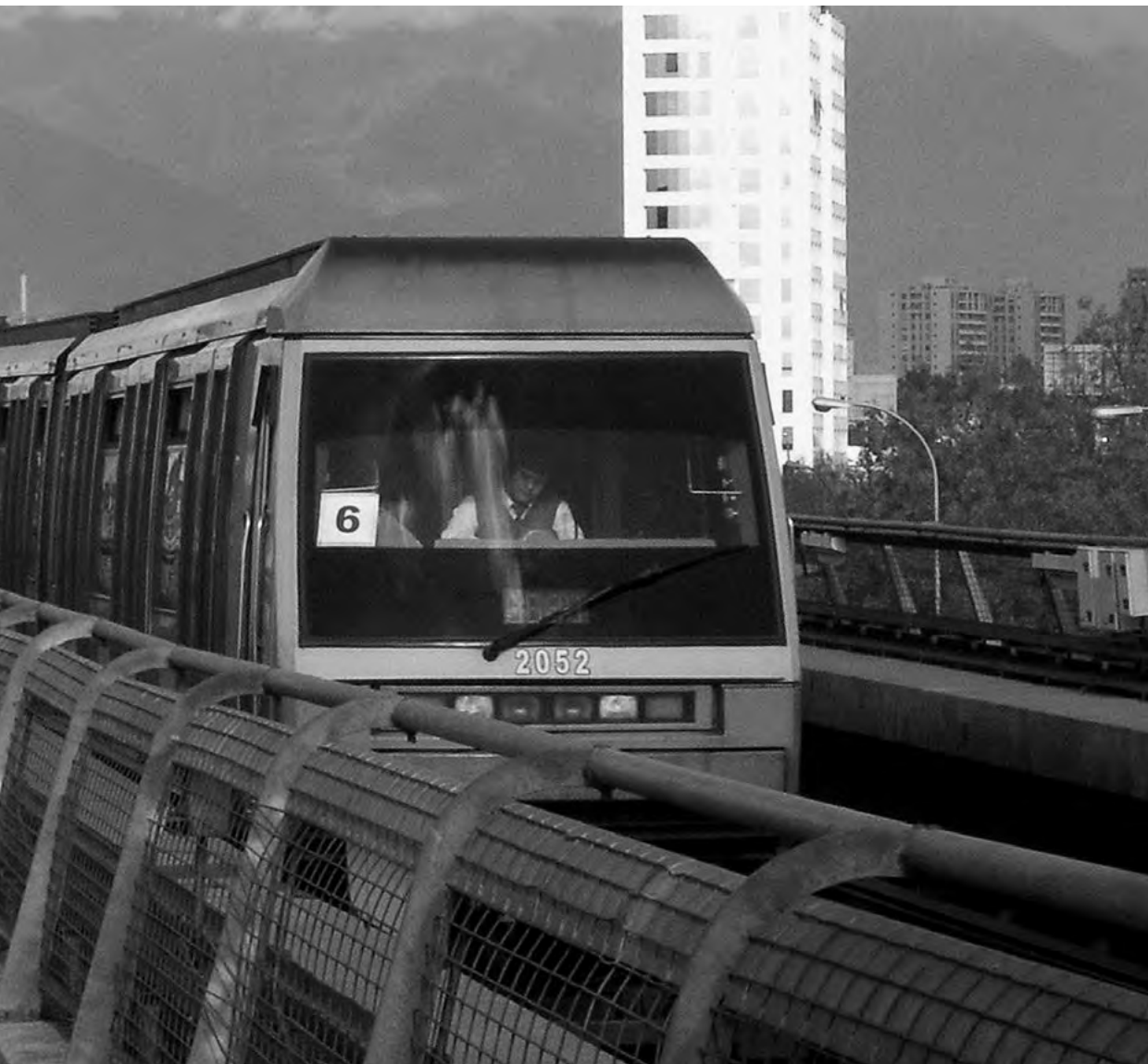
Viaducto elevado línea 5 Metro de Santiago, altura estación Mirador. / Elevated viaduct Metro de Santiago line 5, near Mirador station. ©Ariel Cruz / Creative Commons
