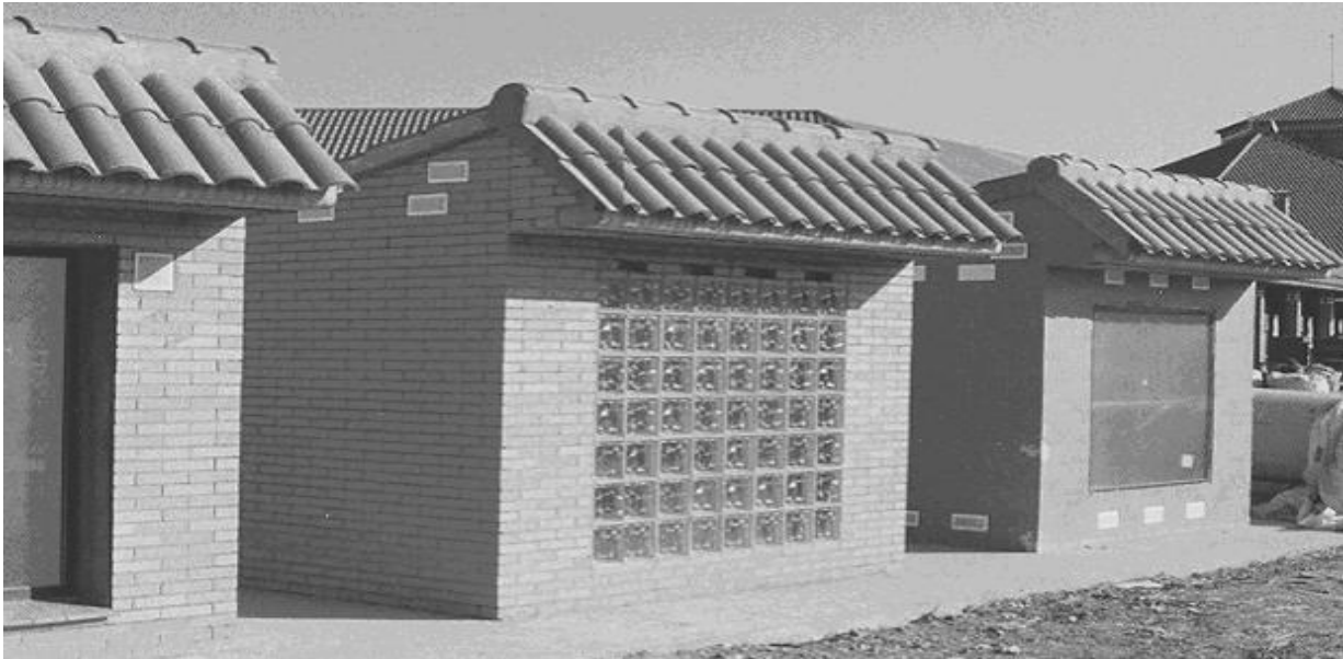
Fig. 7: Casetas donde se probaron los PCM de temperaturas 20, 23 y 26 °C. Toledo (España).
