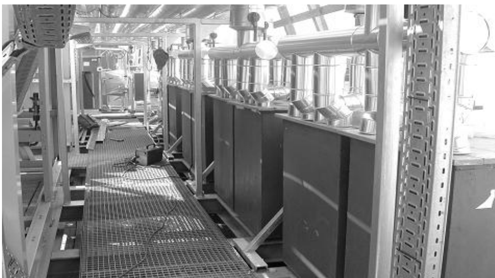
Fig. 8 Montaje de una instalación de climatización de 28 m 3 de PCM de temperatura 7°C. Madrid
