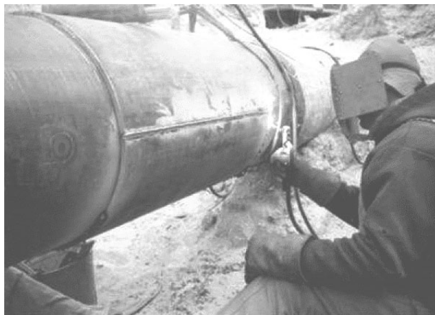
Fig.1: Reparación en un tramo de Gasoducto
