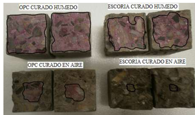
Fig. 7: Frente de carbonatación en probetas a/cm=0,5 . Sección transversal cuadrada de 50 mm de lado (adaptada de Lizarazo, 2010)
