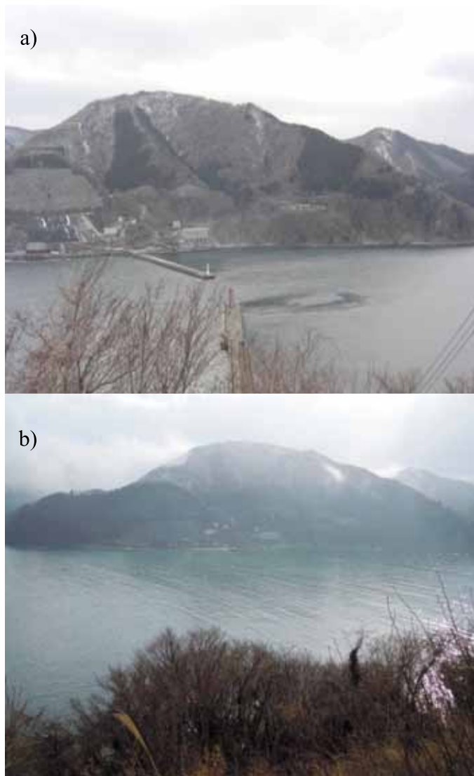
Figura 6: a) Rompeolas en Onagawa antes del tsunami y b) después del tsunami. Notar que prácticamente no hay vestigios del rompeolas
