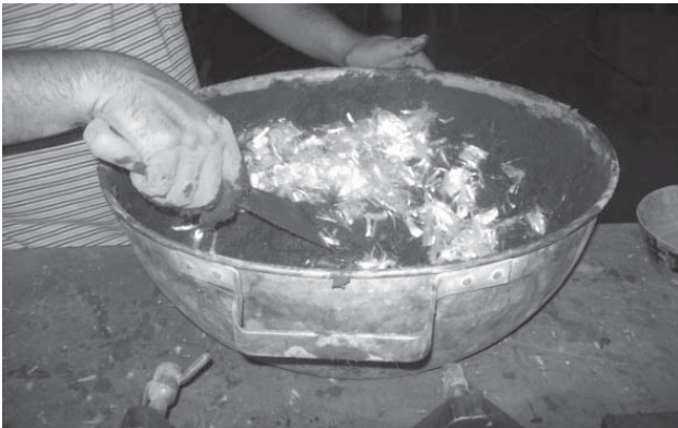
Ilustración 3. Preparación de la mezcla de adobe con incorporación de fibras
