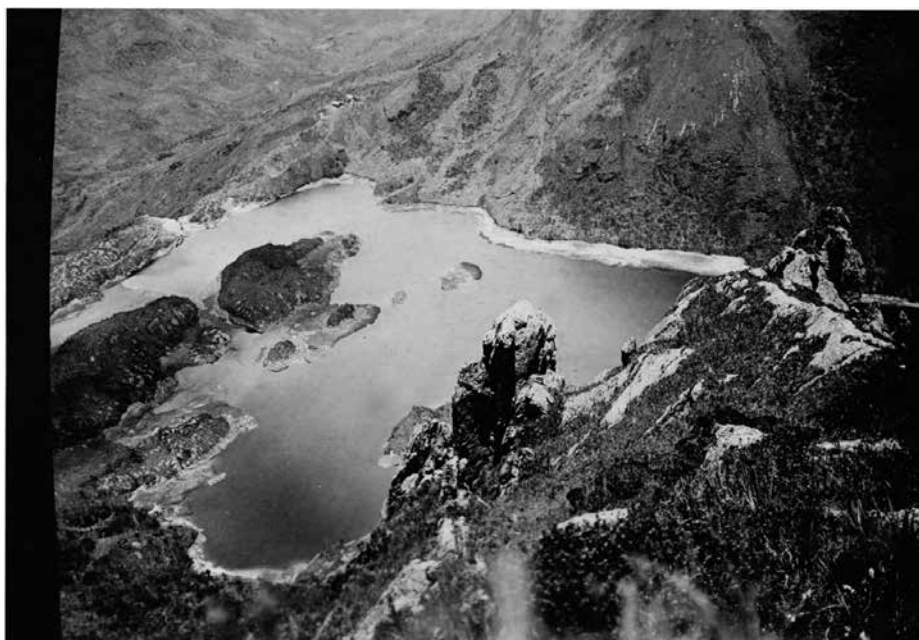
Figura 2. Proceso de desagüe de la laguna de Ayllón, 1941.
