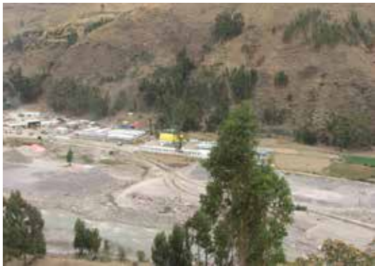
Figura 1. El campamento de construcción de la carretera interoceánica.
