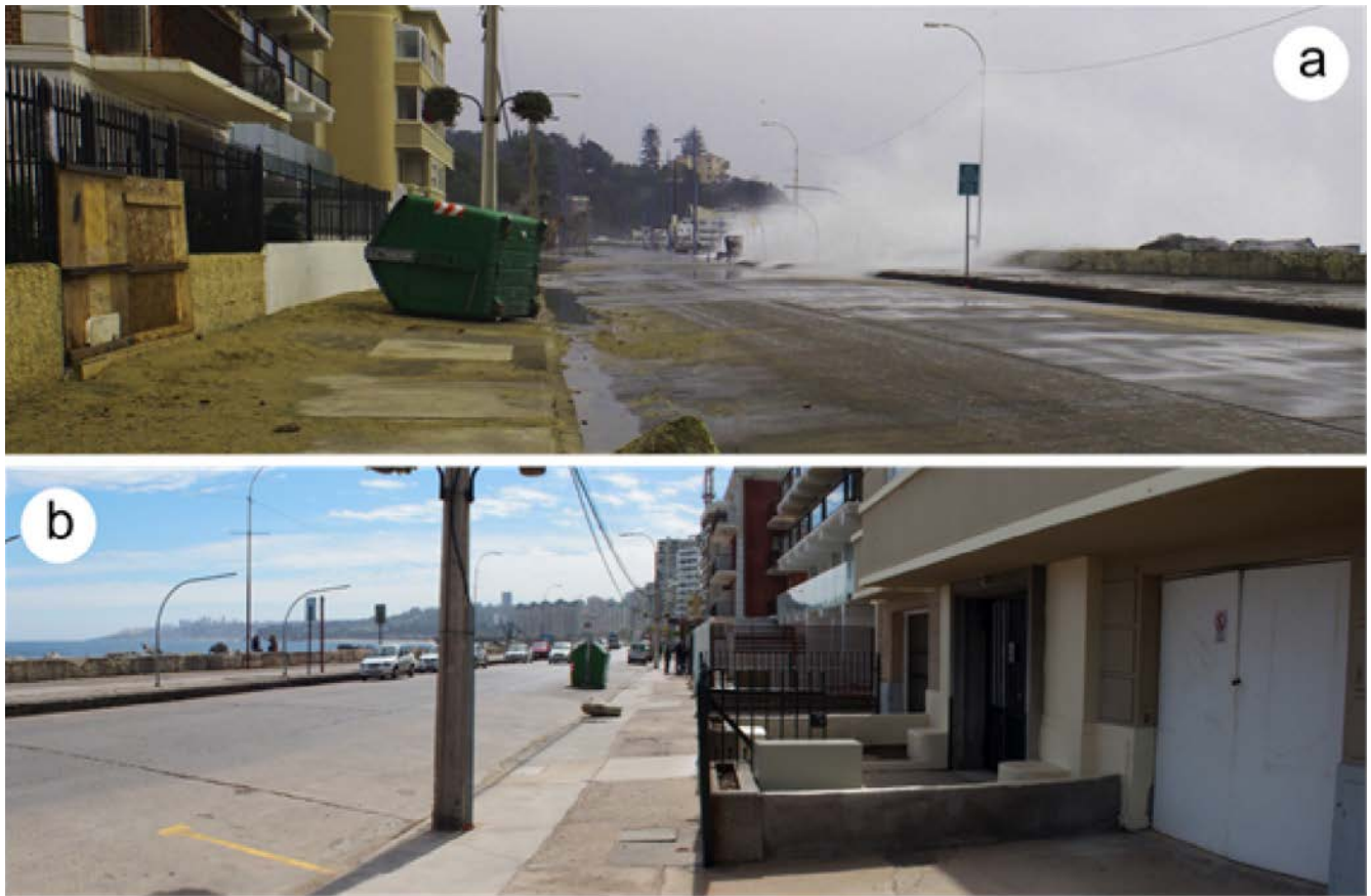
Figura 1. (a) Oleaje sobrepasando defensa costera en la avenida Perú (julio, 2017). (b) Exposición de primeros pisos en la avenida Perú (septiembre, 2017).
